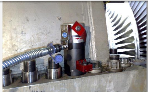
Conexão de parafuso de carcaça da turbina
