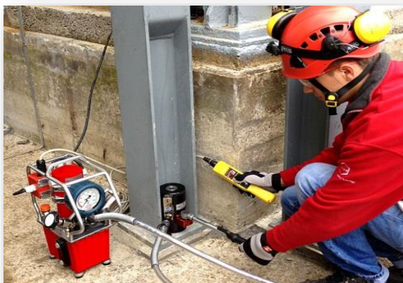
Conexão de parafuso de fundação
