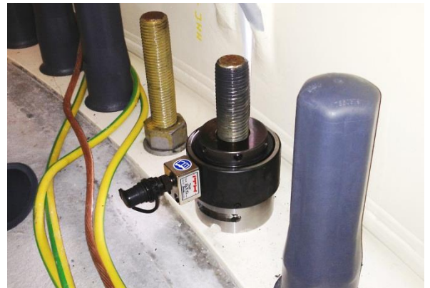
Tensionamento de parafuso de fundação
