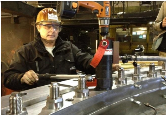
União aparafusada em torre de panela de fundição
