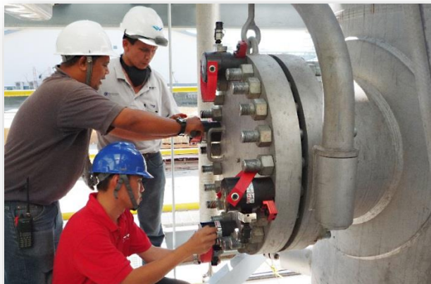
Montagem com um cilindro de estágio único em uma flange ANSI
