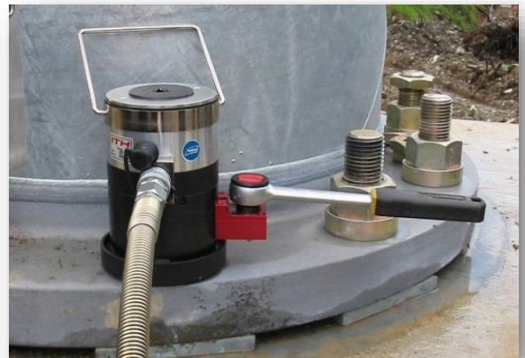
Conexão do parafuso de fundação
