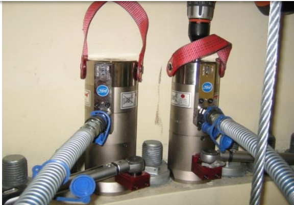
União aparafusada em segmento de turbina eólica
